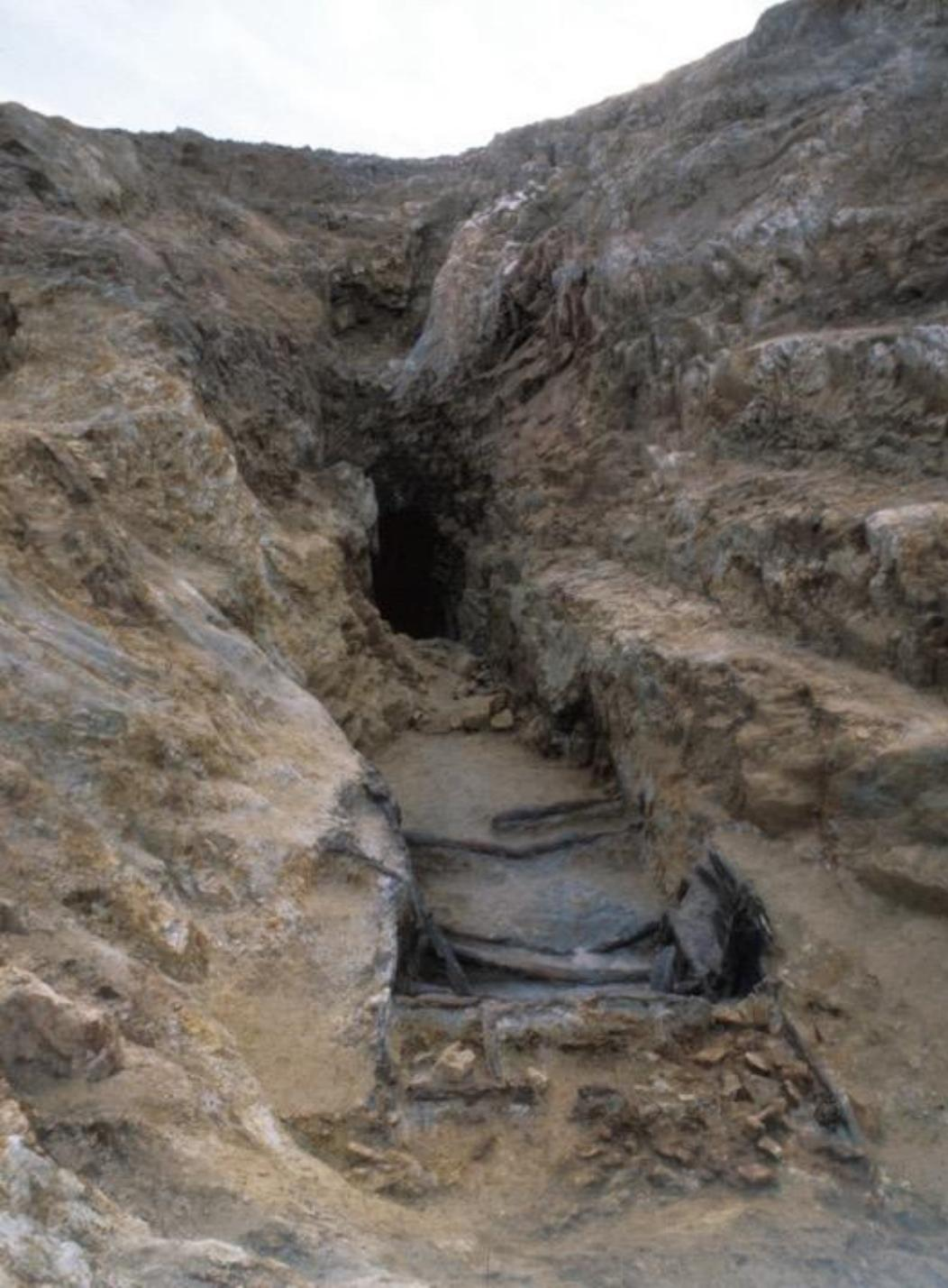
À La Fagassière (Château-Chervix, Haute-Vienne), chantier d'exploitation ouvert en fond de fosse et restes d'étayage en bois. A droite, les gradins antiques à ciel ouvert (Cauuet 2004)
